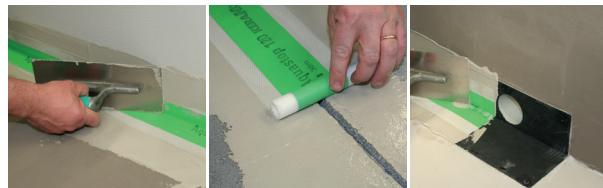
Στεγανοποιείστε τους κατασκευαστικούς αρμούς με την Aquastop 200 HP, την ελαστική στεγανοποιητική ταινία για κάτω από τα πλακίδια από καυτσούν NBR, επενδυμένο και στις δύο πλευρές με μη υφασμένο πολυπροπυλένιο με υψηλή πρόσφυση.
